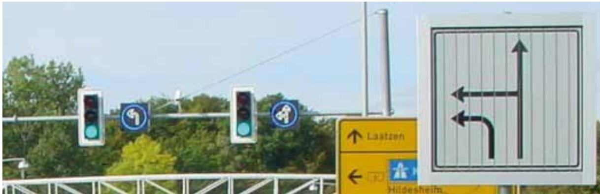
Abb. 61 Beispiel einer dynamischen Fahrstreifenzuteilung an Knotenpunkten
