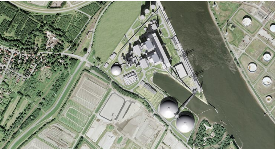
Das Kraftwerk Moorburg im Jahr 2012
