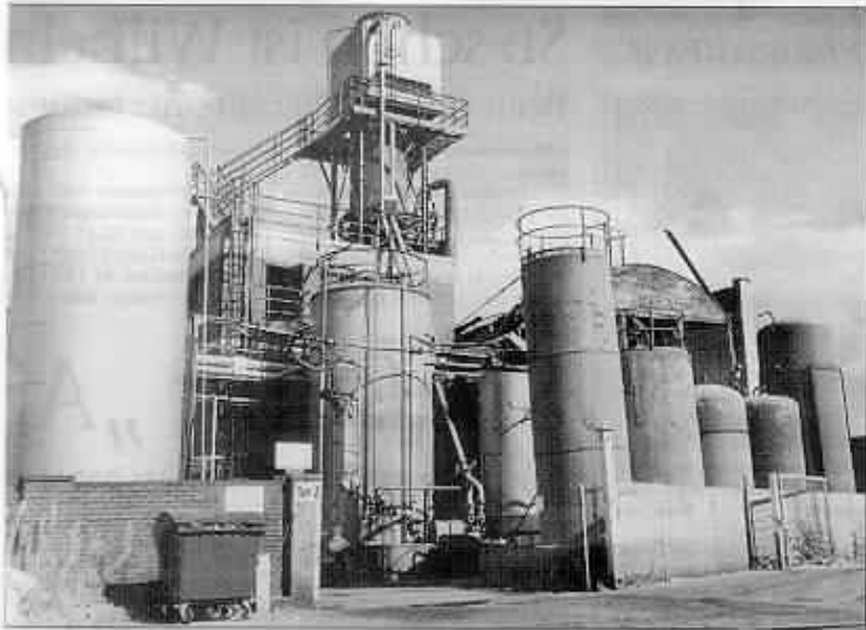
Die bei der Explosion am Sonntag völlig zerstörte Destillationsanlage der Nordischen Oelwerke soll schnellstmöglich abgerissen und neu aufgebaut werden. Foto: cb
