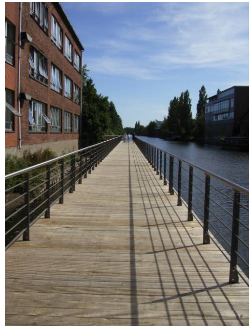
Neue Steganlage Veringkanal
