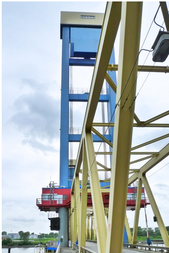
Im Schatten der künftigen Autobahnbrücke erhebt sich die Kattwyk-Brücke. Foto © Thomas Edelmann
