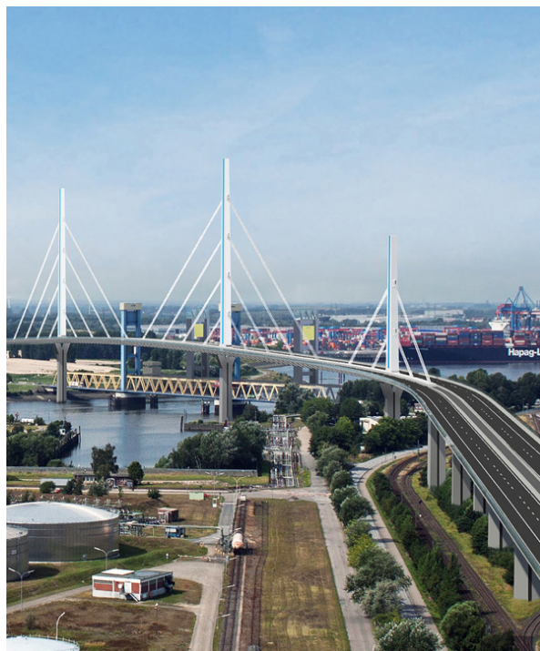
Der 2. Platz von Kinkel + Partner sieht vier Pylone und markante Stahlseilverbindungen vor. Foto © Kinkel + Partner
