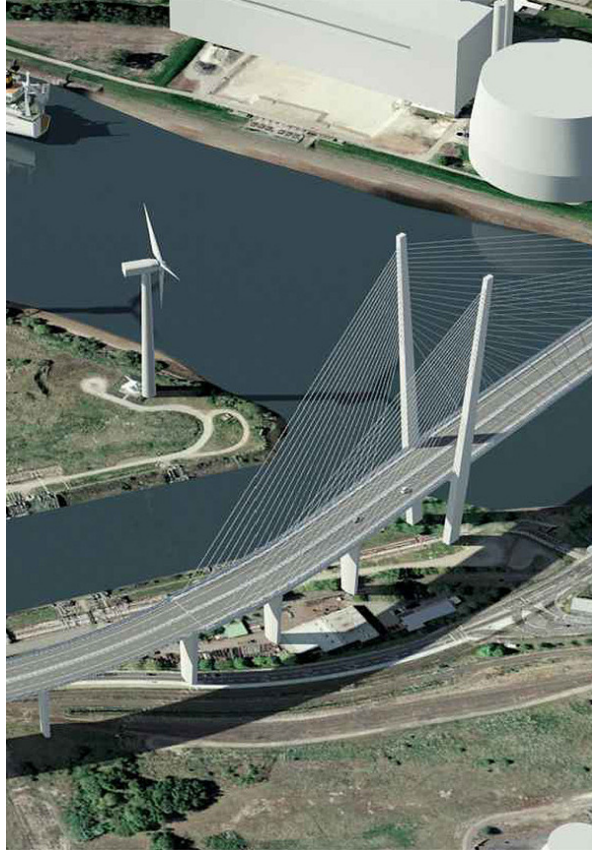
„Hafenquerspange“ auf slowenisch: der Entwurf des Ingenieurbüros Ponting d.o.o. geht von zwei schräg aufstrebenden Pylonen aus. Foto © Ponting d.o.o.
