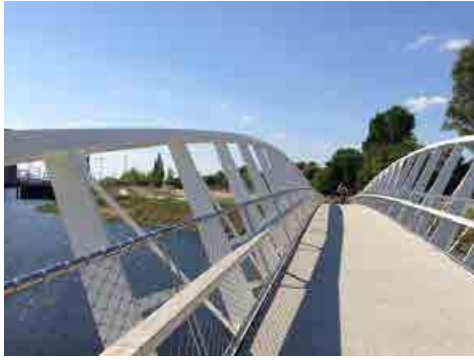
Brücke über den Veringkanal
