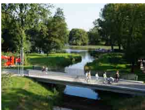
Wilhelmsburger Inselpark, Kuckucksteich
