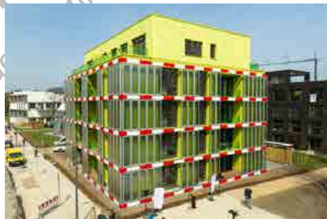
BIQ – ein Smart Material House (Foto: IBA Hamburg)
