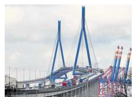
Die Köhlbrandbrücke muss demnächst grundlegend erneuert werden
