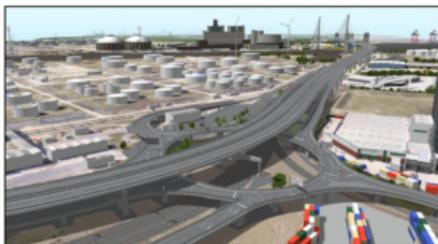
Planung für die A26-Ost: Die Hafenbahn soll nach Fertigstellung der A26-Ost unter der Autobahn und den Autobahnanschlüssen liegen.
