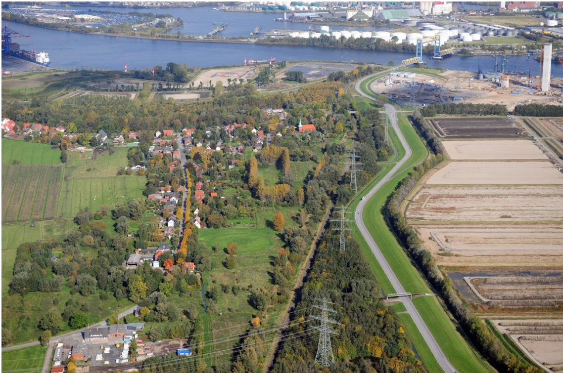
Abb. 9 Abb. 7 Landschaftsbildensembel Moorburg Kattwykbrücke (Aufnahme 2008, Kraftwerk Moorburg noch im Bau)
