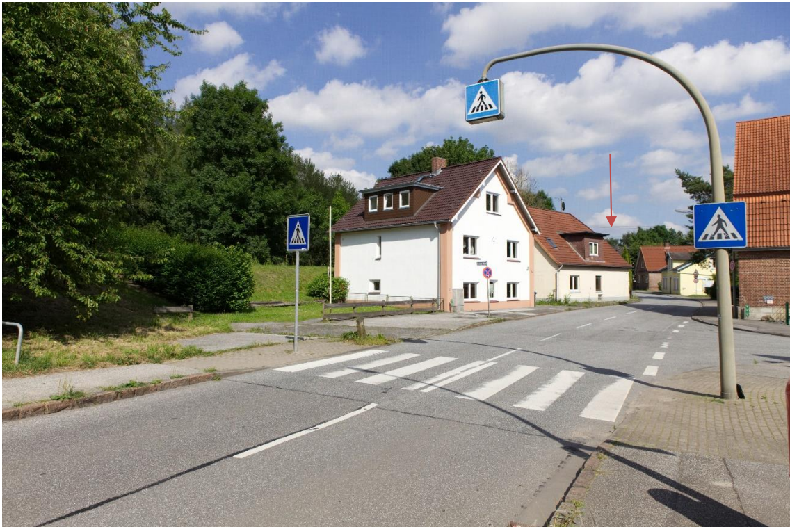
Abb. 22 Abb. 20 Blick vom Moorburger Elbdeich weiter westlich Richtung Kraftwerk Moorburg mit A 26 (Fotomontage, der Pfeil kennzeichnet die Lärmschutzwand auf der A 26)
