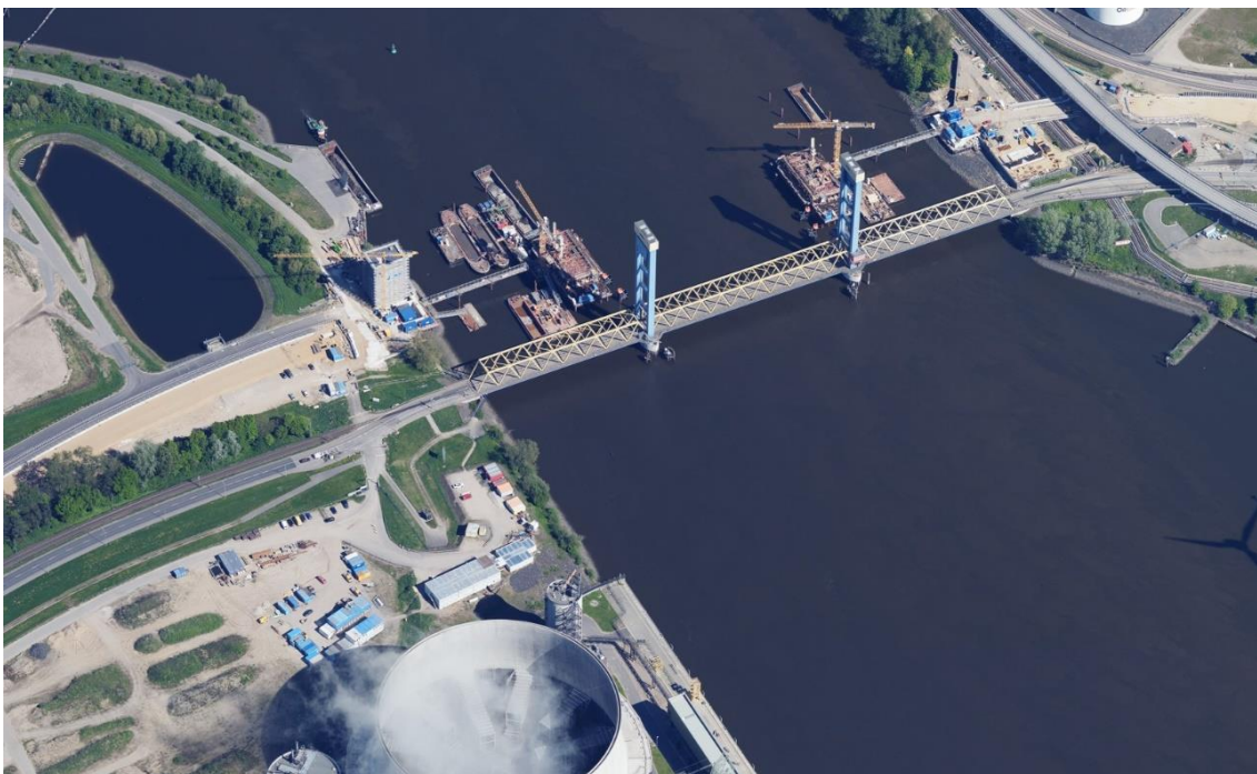
Abb. 12 Abb. 10 Die Süderelbe im Bereich Kattwykbrücke 2018, die Neue Bahnbrücke Kattwyk (NBK) befindet sich im Bau (Quelle: www.geoportal-hamburg.de )
