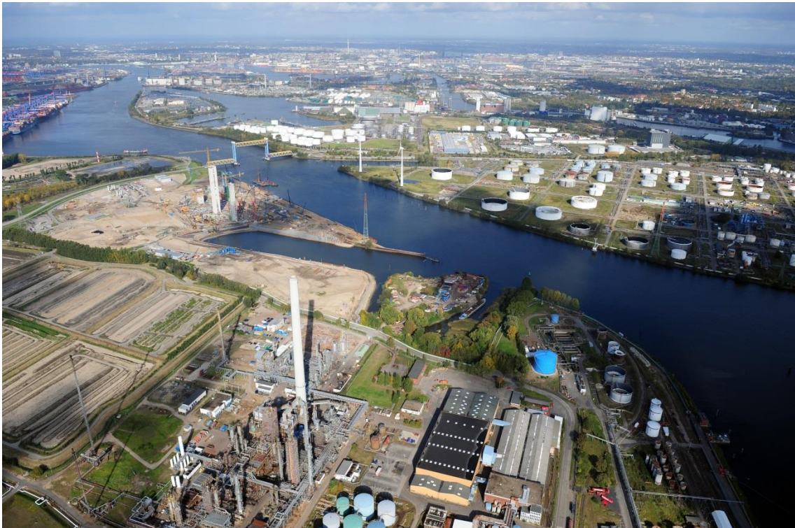
Abb. 11 Abb. 9 Süderelbe-Achse Richtung Norden (Aufnahme 2008, Kraftwerk Moorburg noch im Bau)
