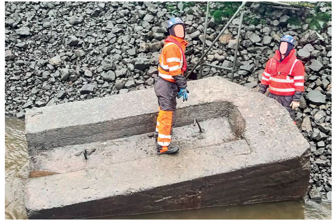
Abb. 3: Bergung des Stahlbetonklotzes aus der Fahrrinne Quelle: Taucher Knoth
