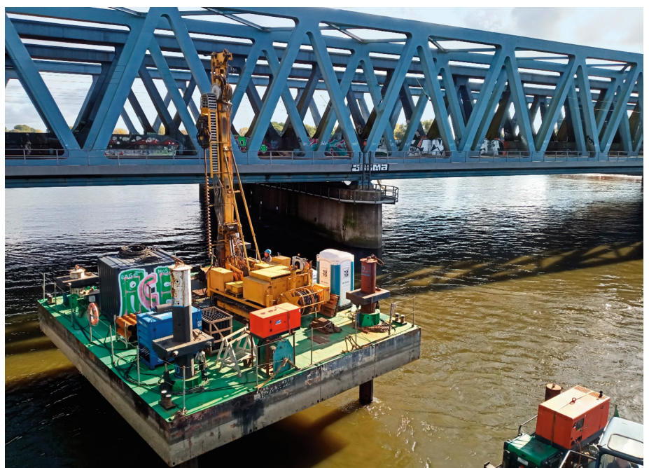
Abb. 1: Bohrgest auf Stelzenponton, vom Korb des Schwimmkrans aus gesehen
