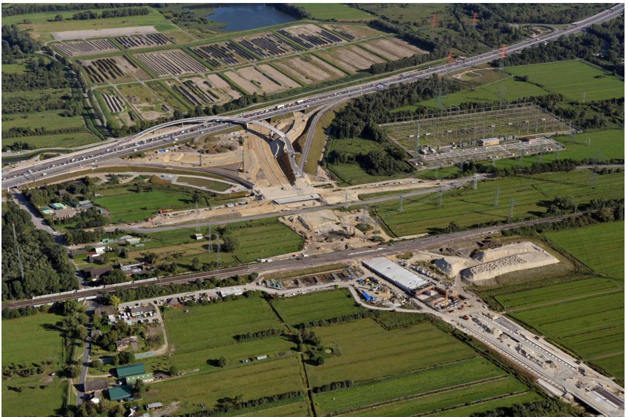
Abbildung 4: Bautenstand der A 26 West im September 2025 (Bildnachweis: Hajo Dietz)
